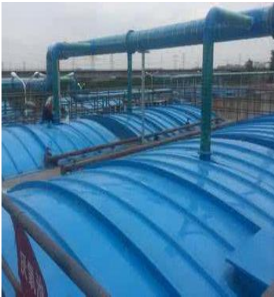
污水收集池加盖
